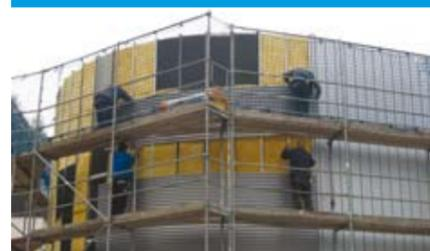
Wärmedämmung und Fassade werden montiert
